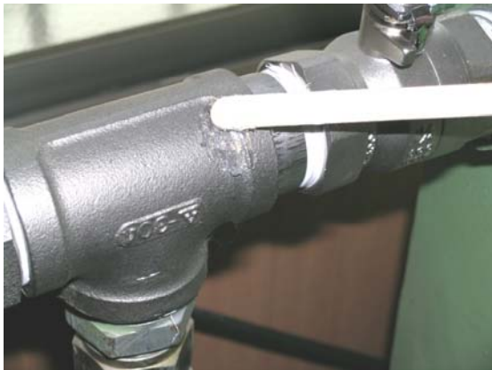
真空系统填缝、修补
